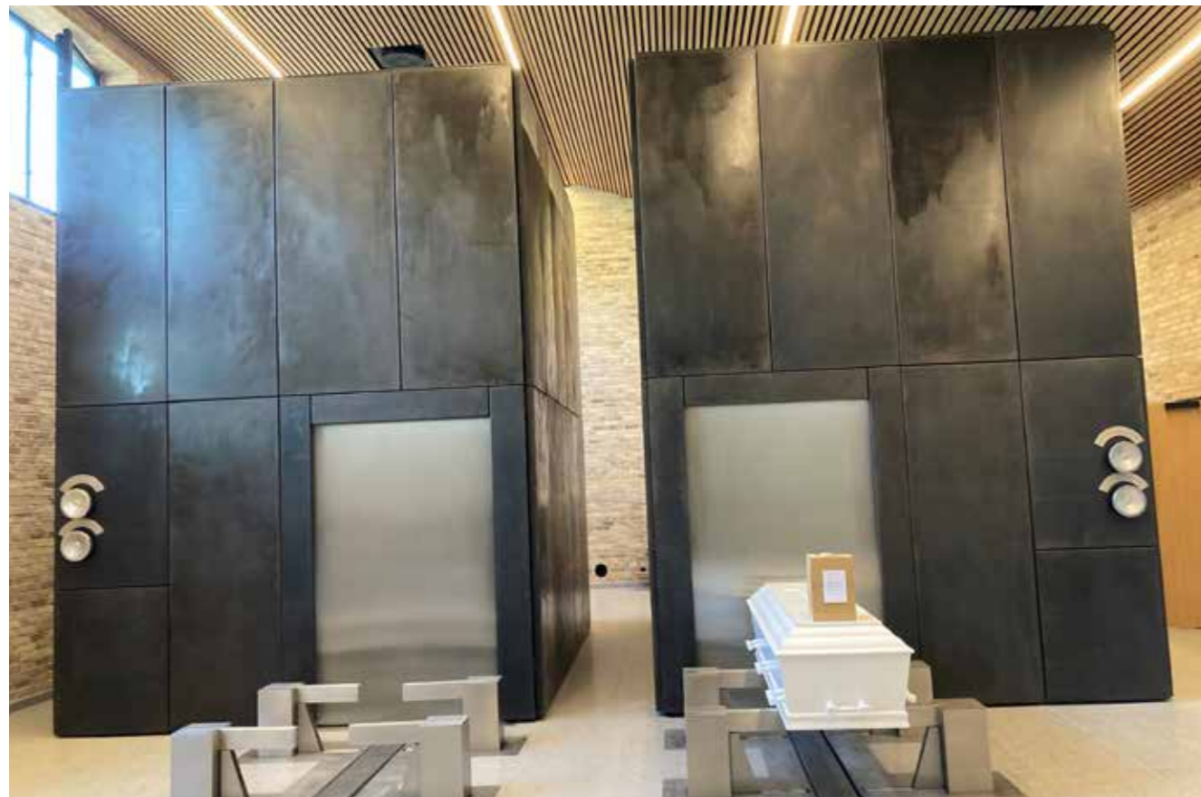
Krematoriets 2 ovne drives af gas, der giver omkring 80% CO 2 -reduktion, i forhold til traditionel fossil gas.
