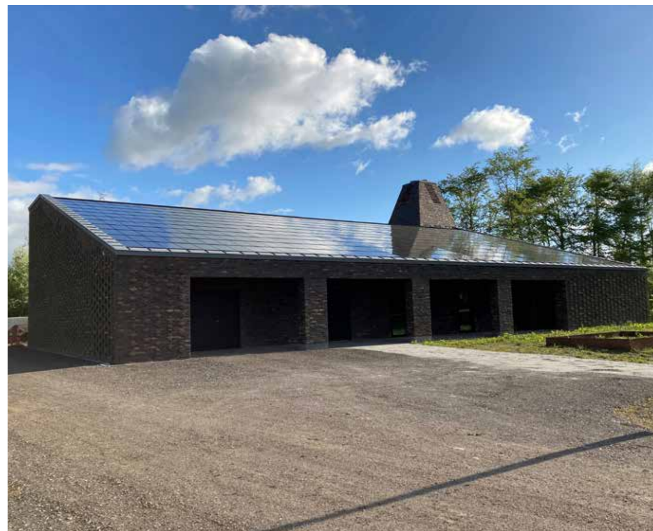
Den 400 m 2 store tagflade udgøres af ét stort solcelleanlæg, der ca. leverer den energi, krematoriets teknik kræver.
